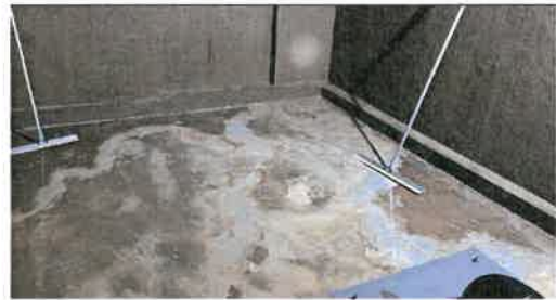
สูบน้ำก่อน และตักไขมัน
