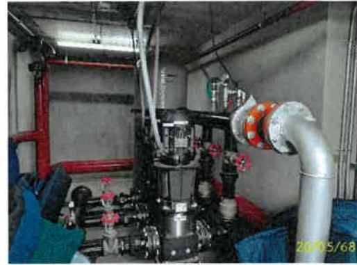
เครื่องสูบน้ำใช้ชั้นดาดฟ้า
