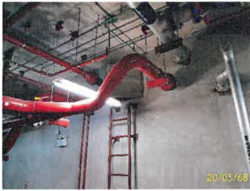
ระบบน้ำสำรองดับเพลิงชั้นใต้ดิน
