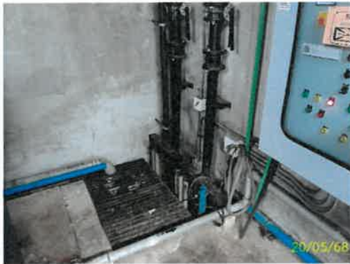
บ่อรับน้ำฝนชั้นใต้ดิน และตู้ควบคุม
