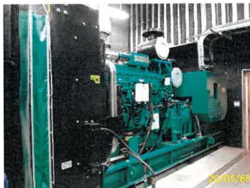
เครื่องสำรองไฟฉุกเฉิน
