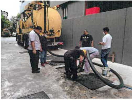
สูบน้ำก่อน และตักไขมัน
