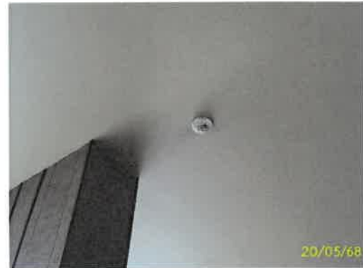
อุปกรณ์ส่งแสงสัญญาณแจ้งเหตุ
