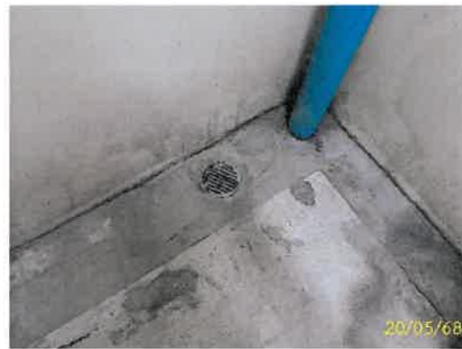
ภาพที่ 2.2-18 ตะแกรงครอบรูท่อน้ำ
