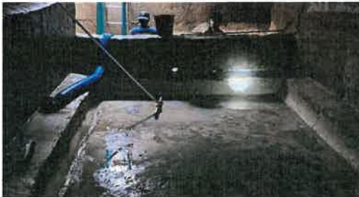
สูบน้ำก่อน และตักไขมัน
