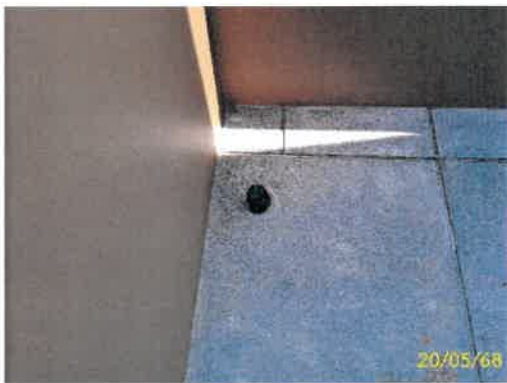
ภาพที่ 2.2-18 ตะแกรงครอบรูท่อน้ำ
