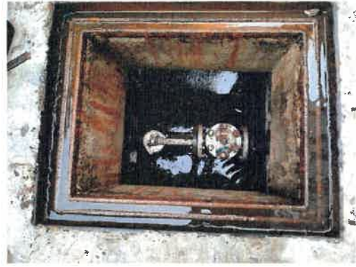
สูบน้ำก่อน และตักไขมัน
