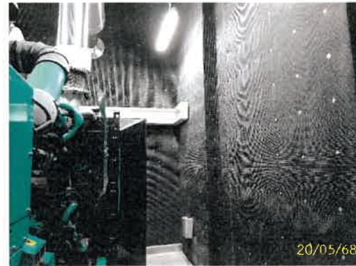
ช่องว่างผนังกันเสียงกับเครื่องกำเนิดไฟฟ้าสำรอง
