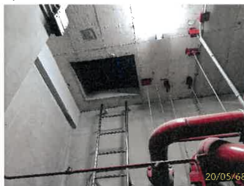
ระบบน้ำสำรองดับเพลิงชั้น 7
